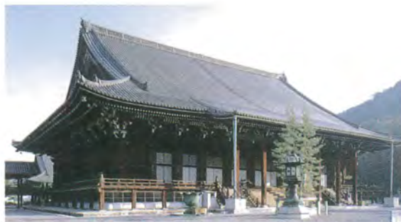
●着工前の大殿(御影堂)
