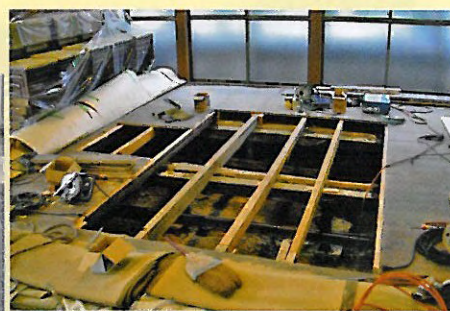
▲本堂床下補強工事 (写真3)
