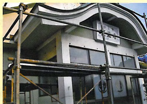
▲モルタルを剥離前
