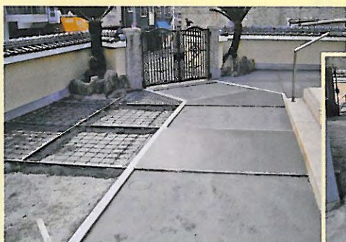
▲本堂前アプローチコンクリート張り替え工事 (写真6)
